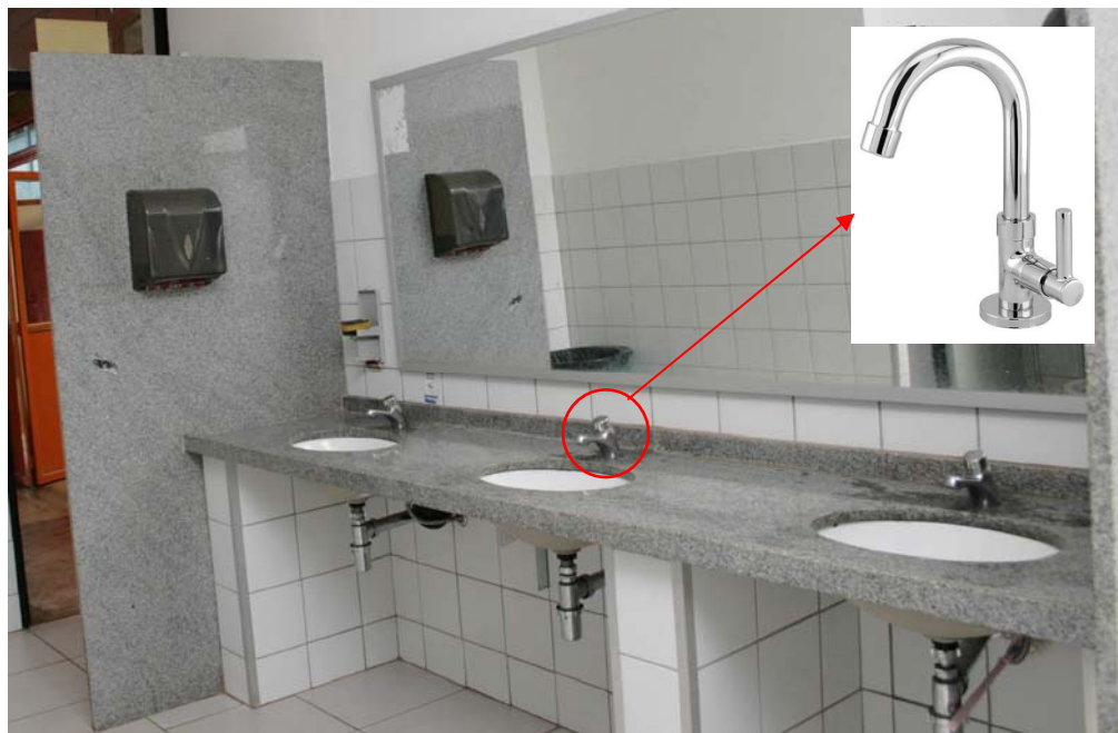
Figura 08 – Modelo de lavatório embutido em granito com torneira bica alta e sifão tipo garrafa.
