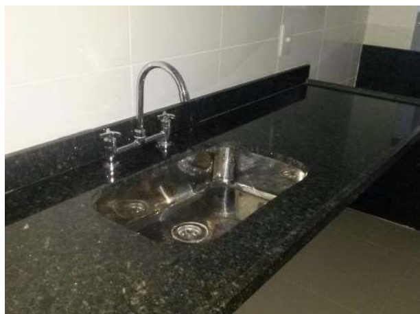
Figura 15 – Modelo de pia em granito com cuba retangular em aço inox e torneira bica alta.
